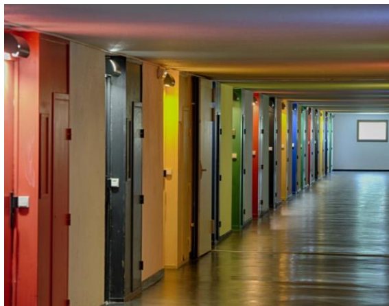
Charles-Edouard Jeanneret dit Le Corbusier, rue intérieure, Unité d'habitation de Firminy, 1965, propriétaire : Office Public d'Habitation de Firminy @ DR / F.L.C / ADAGP
